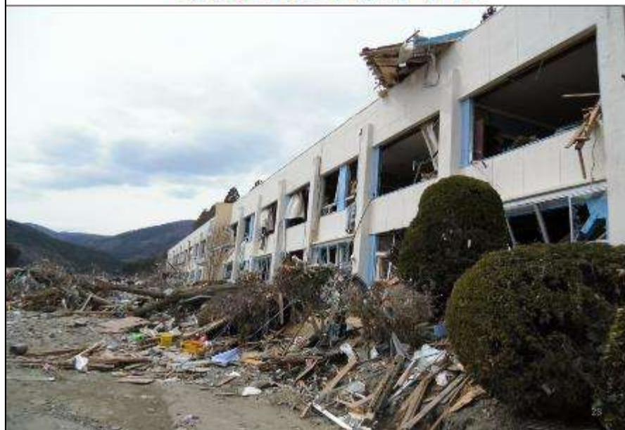
破壊された雄勝小学校
