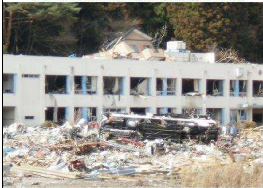
屋上に民家が流れ着いた雄勝小学校
